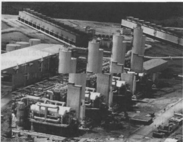
Photo 1. Quatre grandes centrales au Mexique produisent de l'azote sous haute pression afin d'améliorer la récupération du pétrole par injection dans les puits
